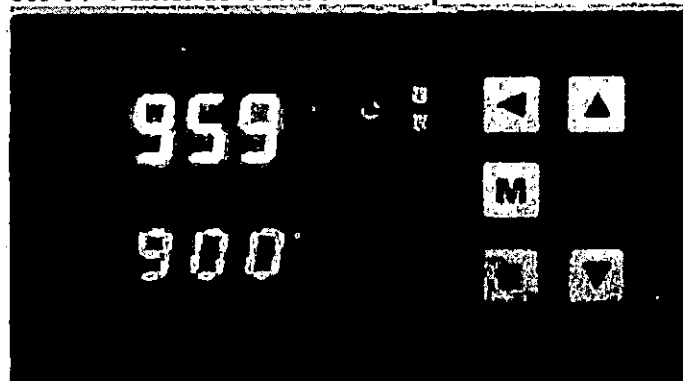
Foto 01- Pannel de Controle: Temperatura Combustão
